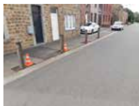
Placement de potelets à Clavier-Station
