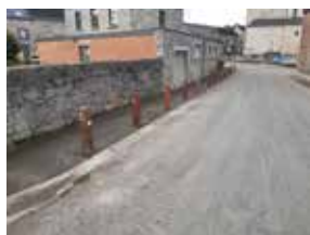
Placement de potelets à Ocquier
